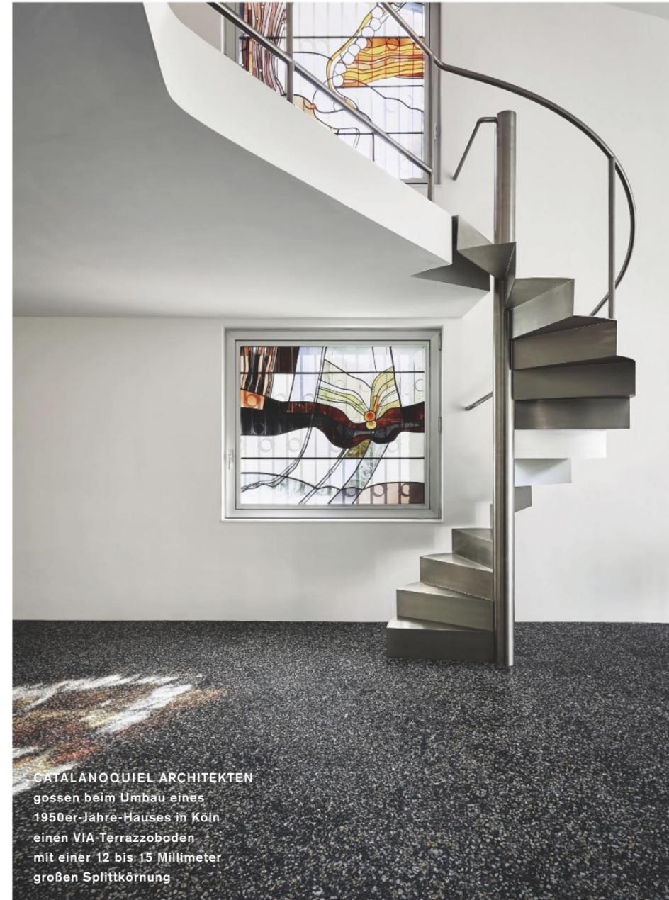
**CATALANOQUIEL ARCHITEKTEN** gossen beim Umbau eines 1950er-Jahre-Hauses in Köln einen VIA-Terrazzoboden mit einer 12 bis 15 Millimeter großen Splittkörnung
